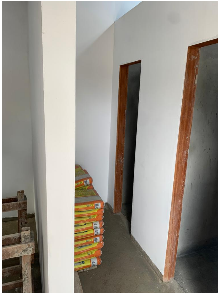
Figura 57 - Paredes com selador aplicado.
