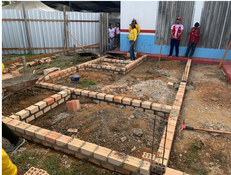
Figura 4 - Alvenaria de Embasamento.
