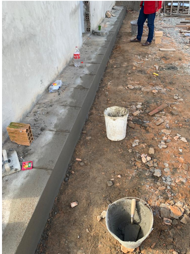
Figura 54 - Finalização da lateral da calçada.
