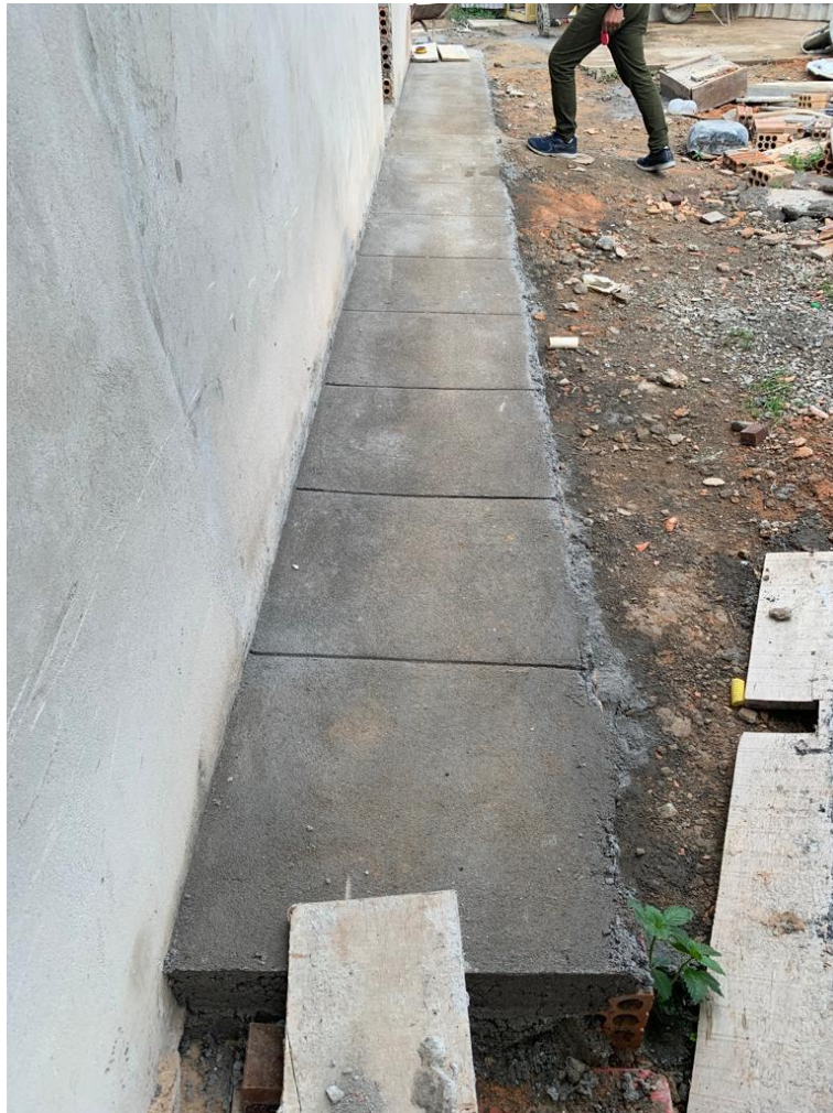
Figura 49 - Execução do piso da calçada.
