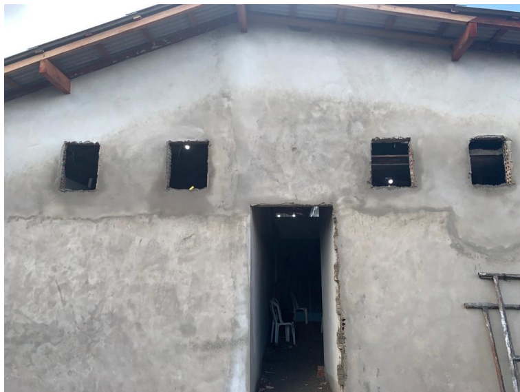
Figura 45 - Parede externa de fundo com reboco finalizado.
