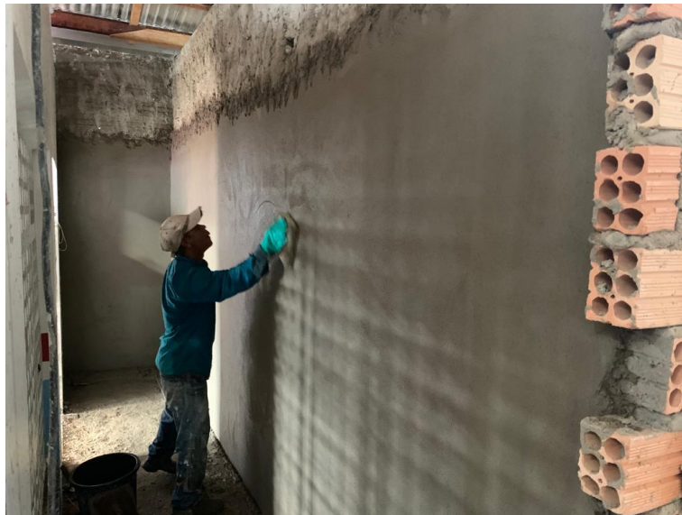
Figura 40 - Reboco parede interna central.
