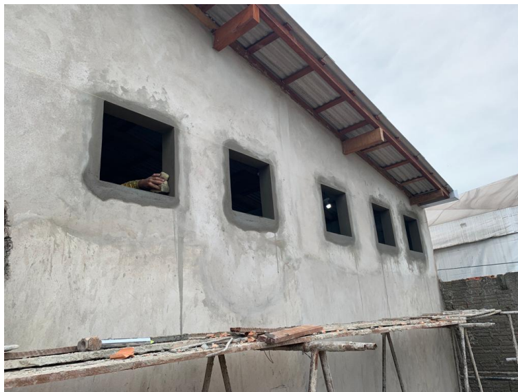
Figura 51 - Execução das aberturas para ventilação.
