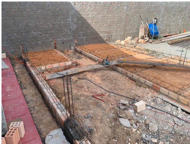
Figura 6 - Preparação para viga baldrame.
