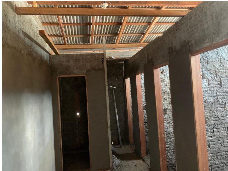
Figura 38 - Reboco interno (chuveiros masculinos).
