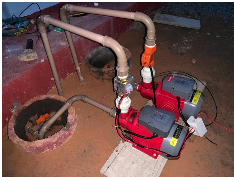
Figura 84 - Sistema de recalque finalizado.
