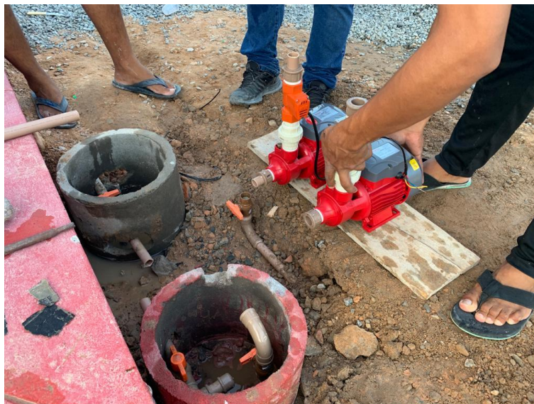
Figura 82 - Instalação de sistema de bombeamento hidráulico.
