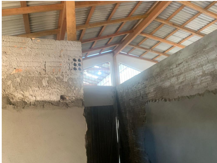
Figura 30 - Continua o do chapisco das paredes internas.
