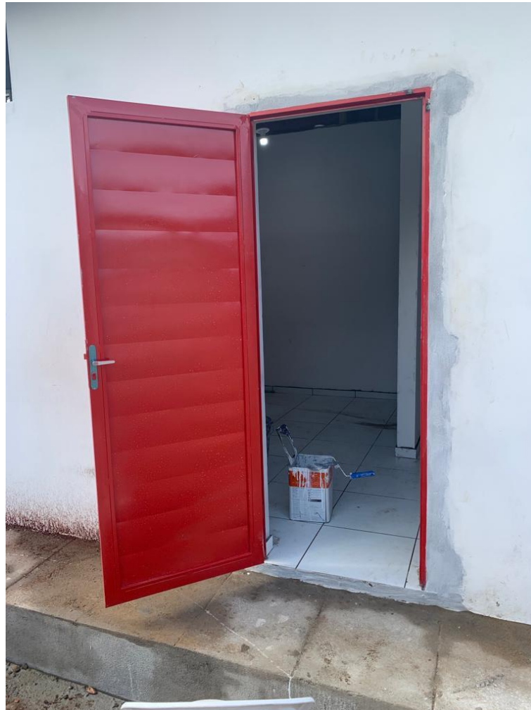
Figura 63 - Instalação das saídas de emergências.
