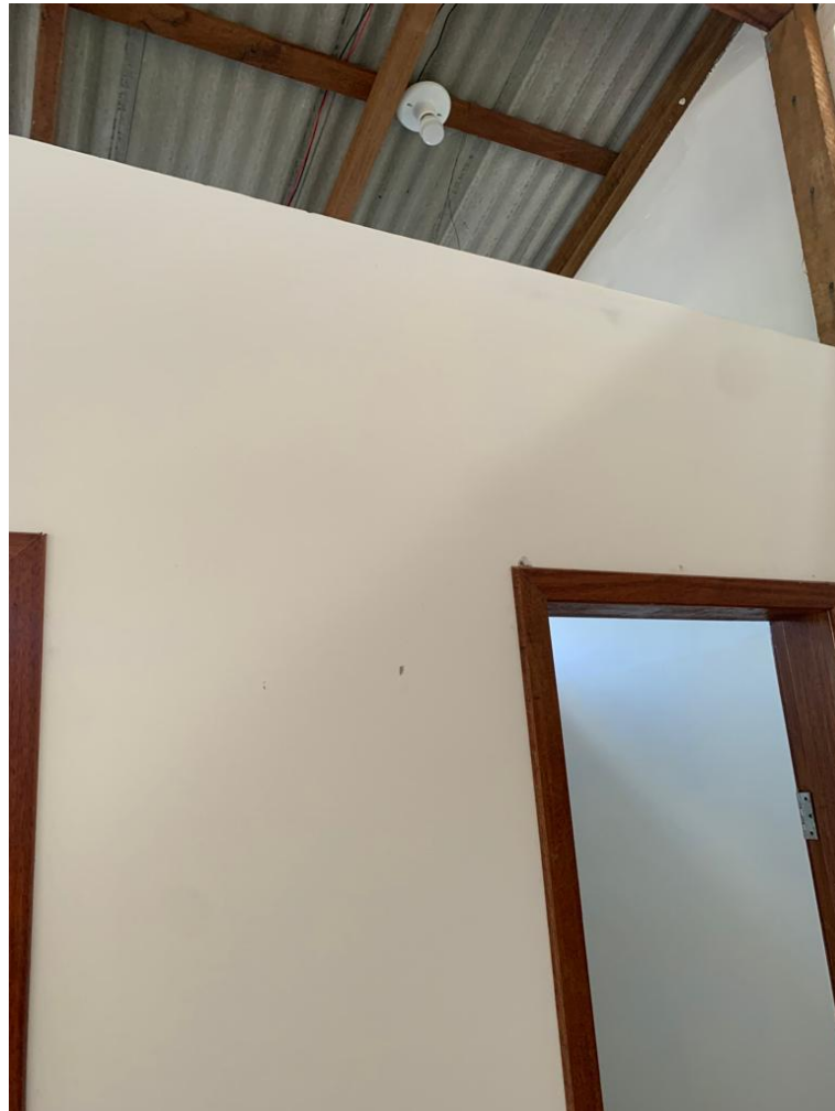
Figura 80 - Paredes internas emassadas e pintadas.
