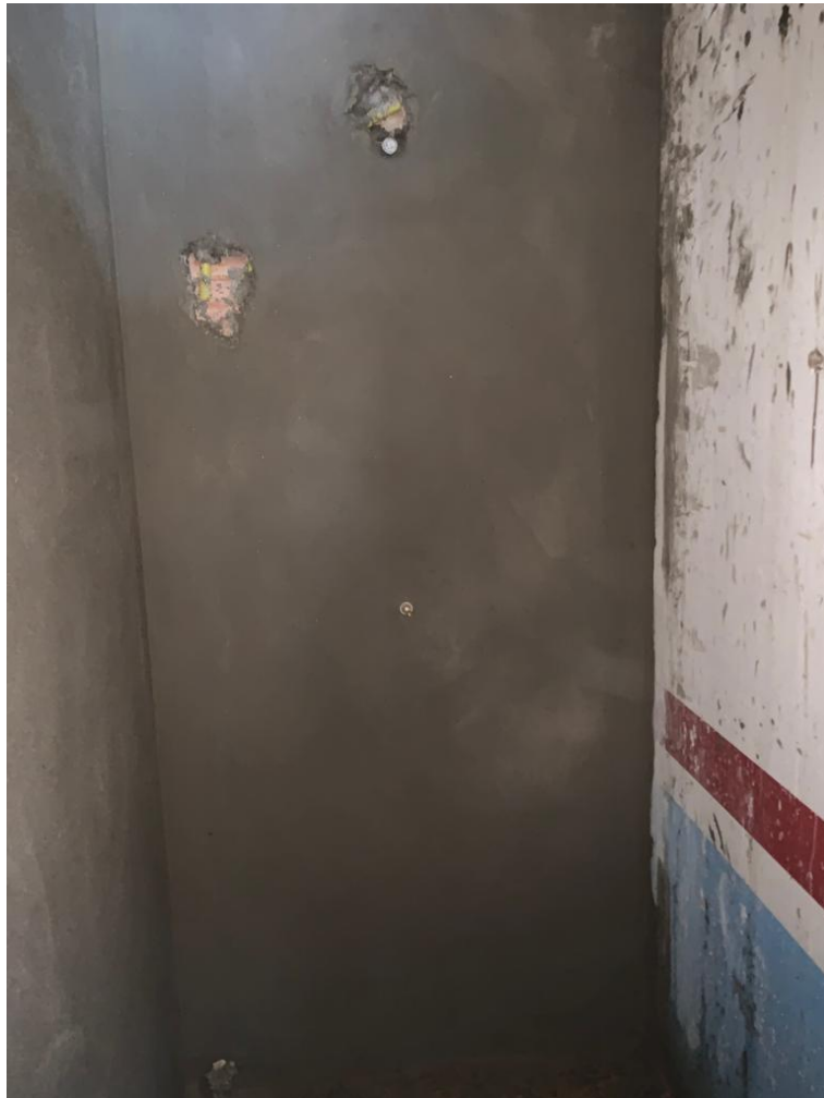
Figura 45 - Parede externa de fundo com reboco finalizado.
