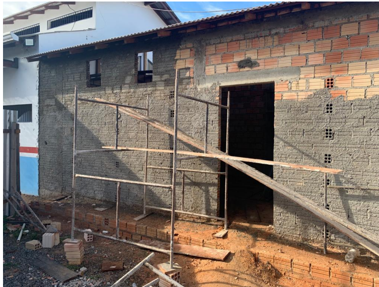
Figura 22 - Chapisco paredes internas e aplicação de batentes das portas.
