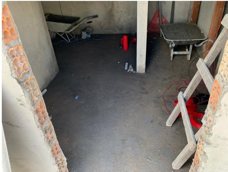
Figura 47 - Execução do contrapiso dos chuveiros.
