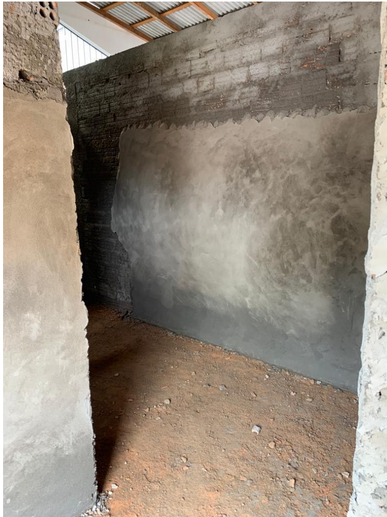
Figura 36 - Continuação do reboco das paredes internas.
