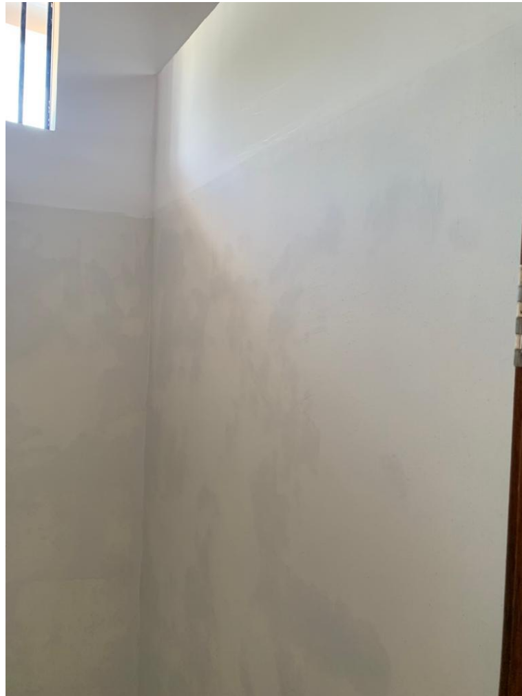
Figura 78 - Aplica o de impermeabilizante na  rea dos chuveiros.
