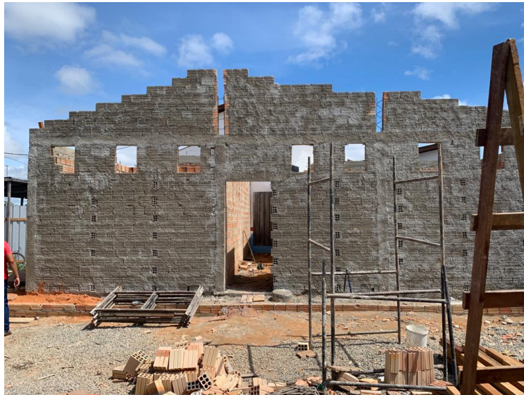
Figura 20 - Execução de paredes externas (alvenaria e chapisco).
