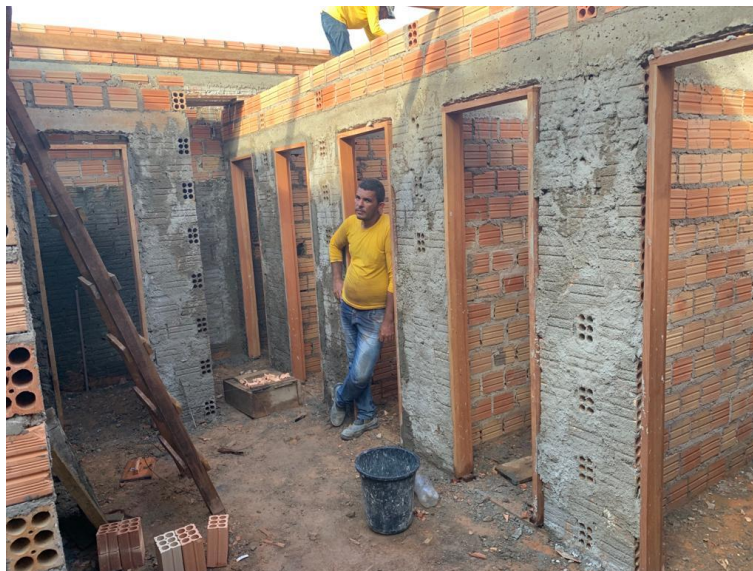
Figura 22 - Chapisco paredes internas e aplicação de batentes das portas.
