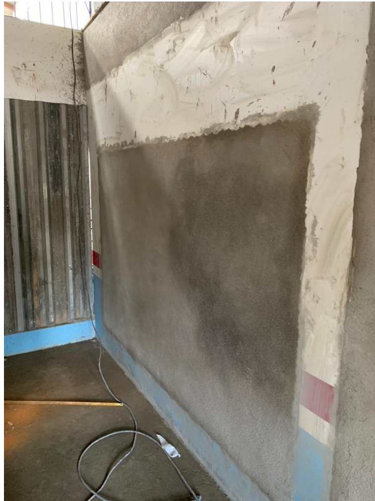
Figura 53 - Reboco da vedação das aberturas finalizado.
