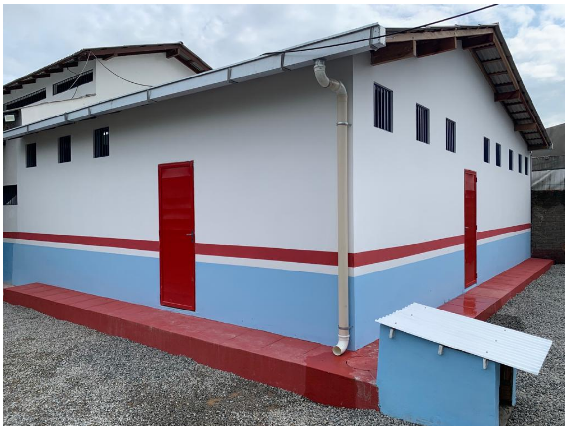
Figura 90 - Área externa da instalação, obra finalizada.
