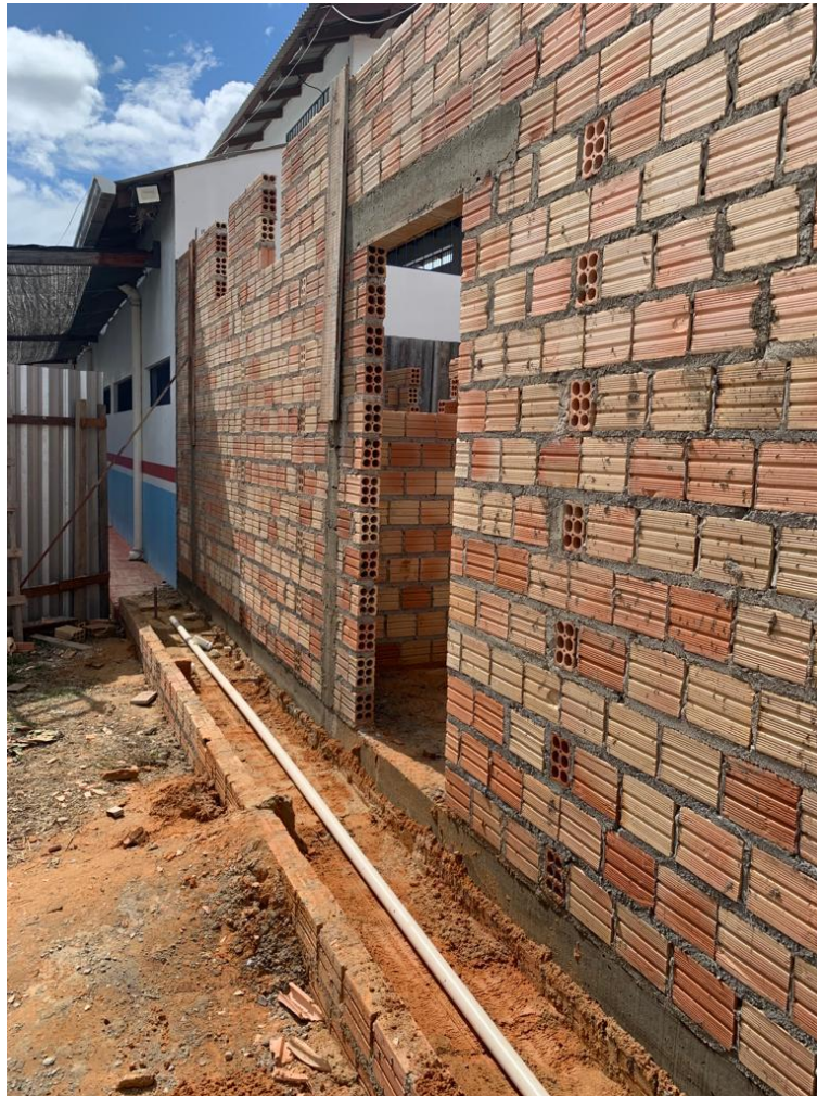
Figura 16 - Execução das paredes externas.
