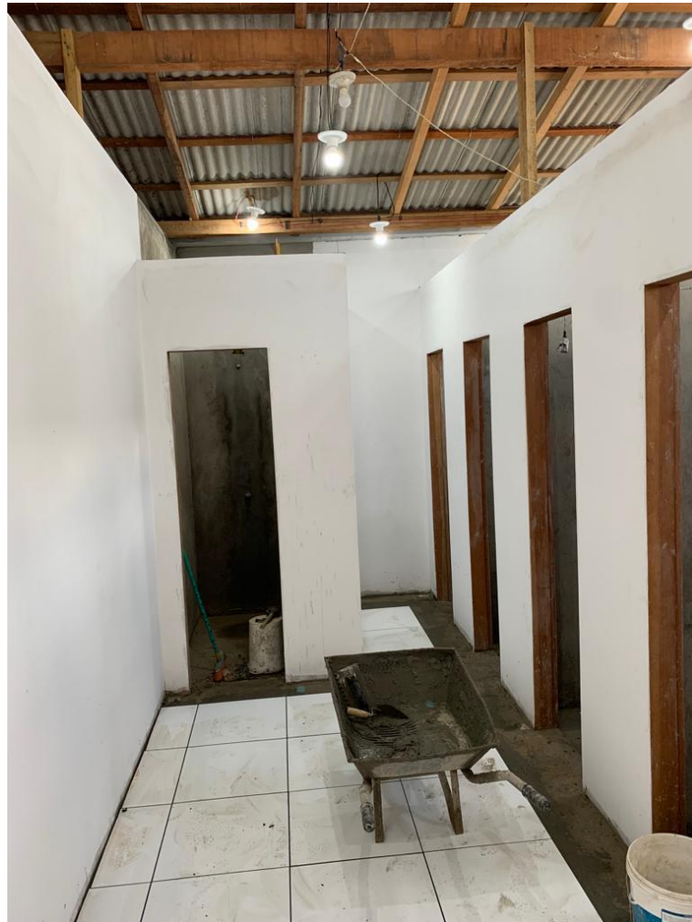
Figura 62 - Paredes internas com selador e aplicação de piso.
