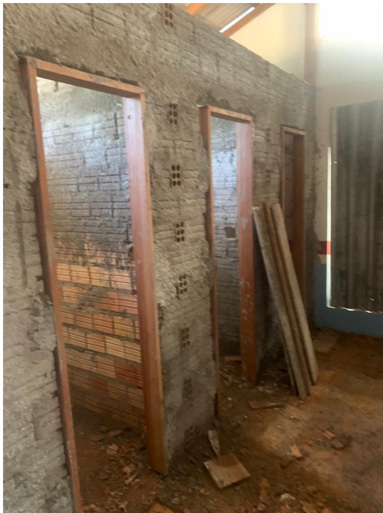
Figura 30 - Continua o do chapisco das paredes internas.
