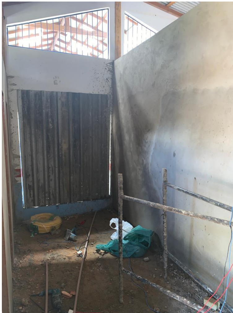
Figura 41 - Reboco interno central finalizado.
