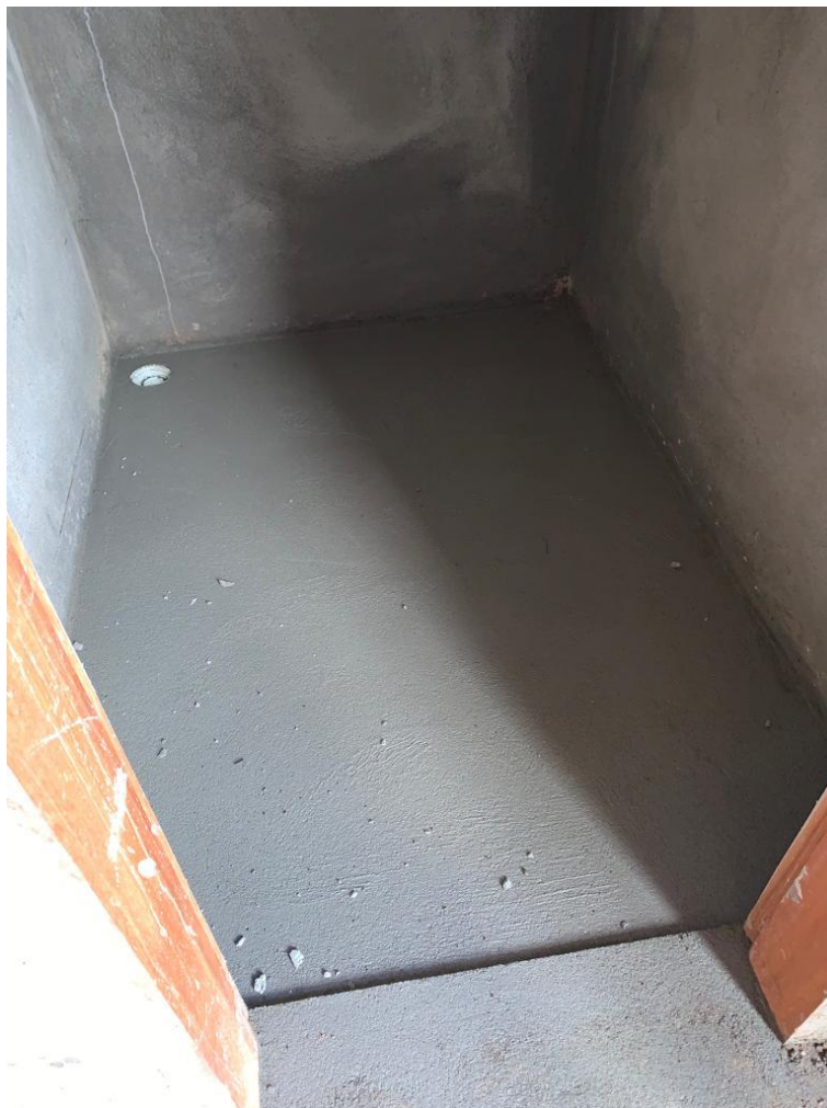
Figura 47 - Execução do contrapiso dos chuveiros.
