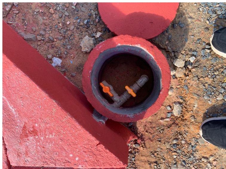
Figura 75 - Execução de caixa de inspeção para registros de água.
