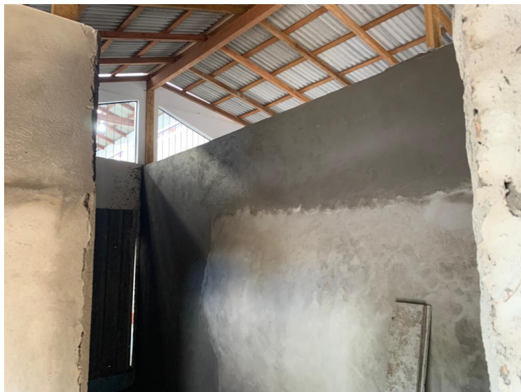
Figura 36 - Continuação do reboco das paredes internas.
