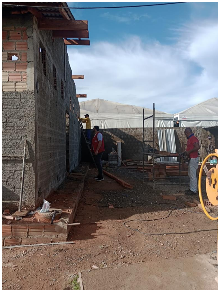
Figura 20 - Execução de paredes externas (alvenaria e chapisco).
