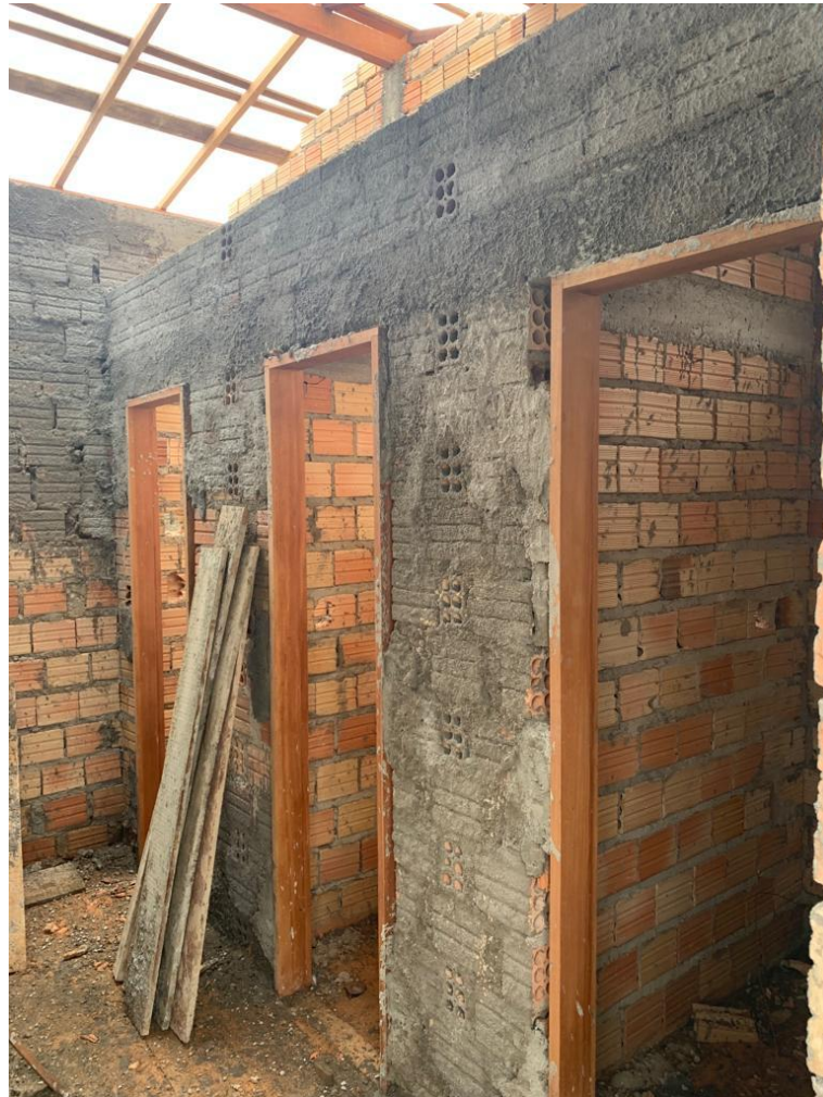
Figura 26 - Chapisco das paredes internas.
