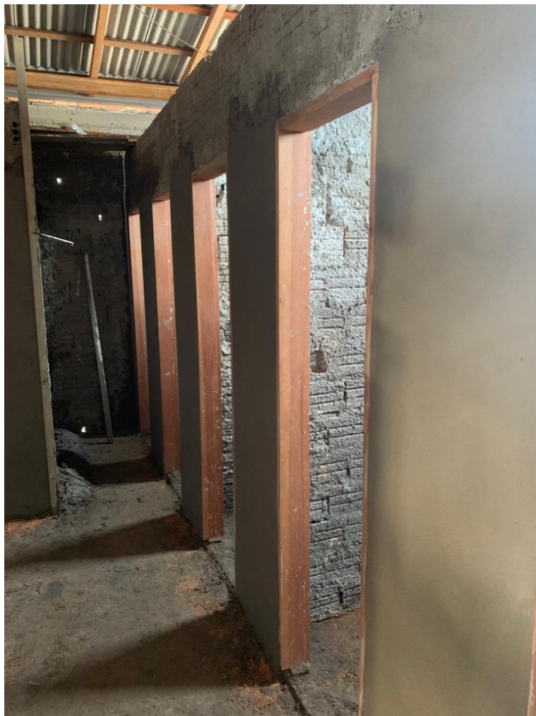
Figura 38 - Reboco interno (chuveiros masculinos).
