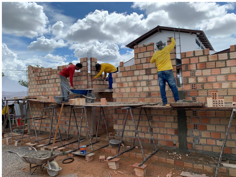
Figura 16 - Execução das paredes externas.
