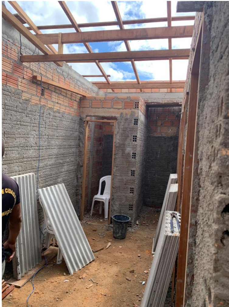
Figura 25 - Chapisco interno e madeiramento do telhado.
