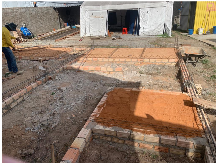
Figura 8 - Continuação do aterramento.
