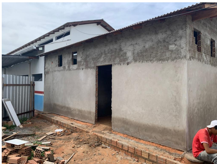
Figura 32 - Continuação do reboco das paredes externas.
