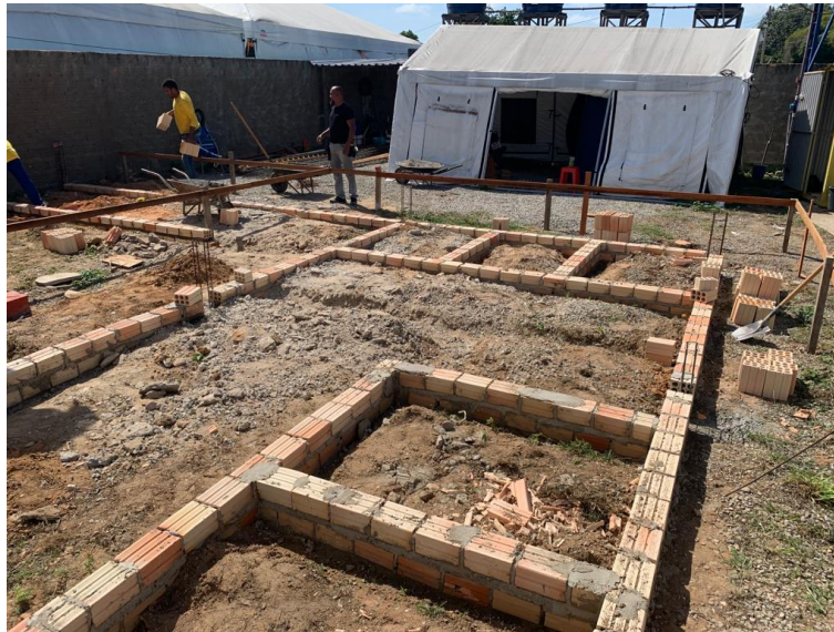
Figura 6 - Preparação para viga baldrame.
