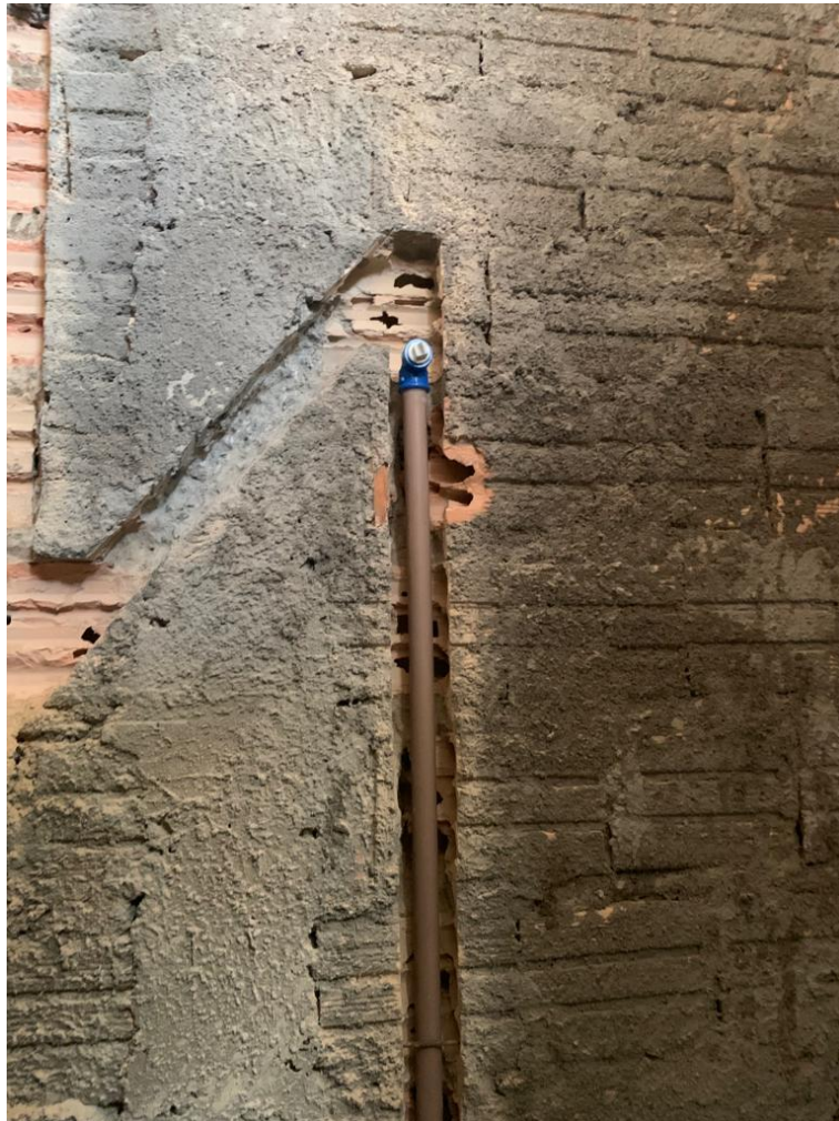
Figura 42 - Rasgo na alvenaria para inserção de tubulação de água.
