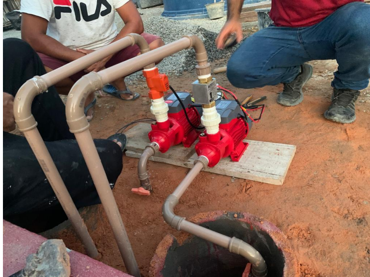
Figura 84 - Sistema de recalque finalizado.
