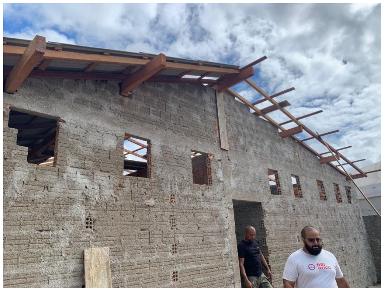
Figura 24 - Execução do telhado e cobertura.
