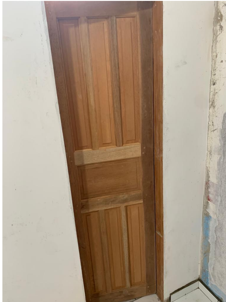
Figura 64 - Instala o das portas dos chuveiros.
