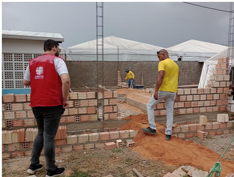
Figura 10 - Paredes externas e armadura do pilar.
