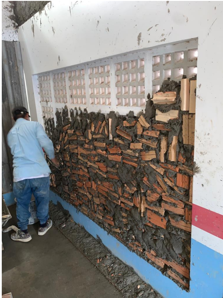
Figura 48 - Vedação dos cobogós.
