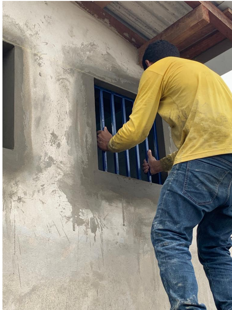
Figura 52 - Inserção das grades de segurança nas aberturas.
