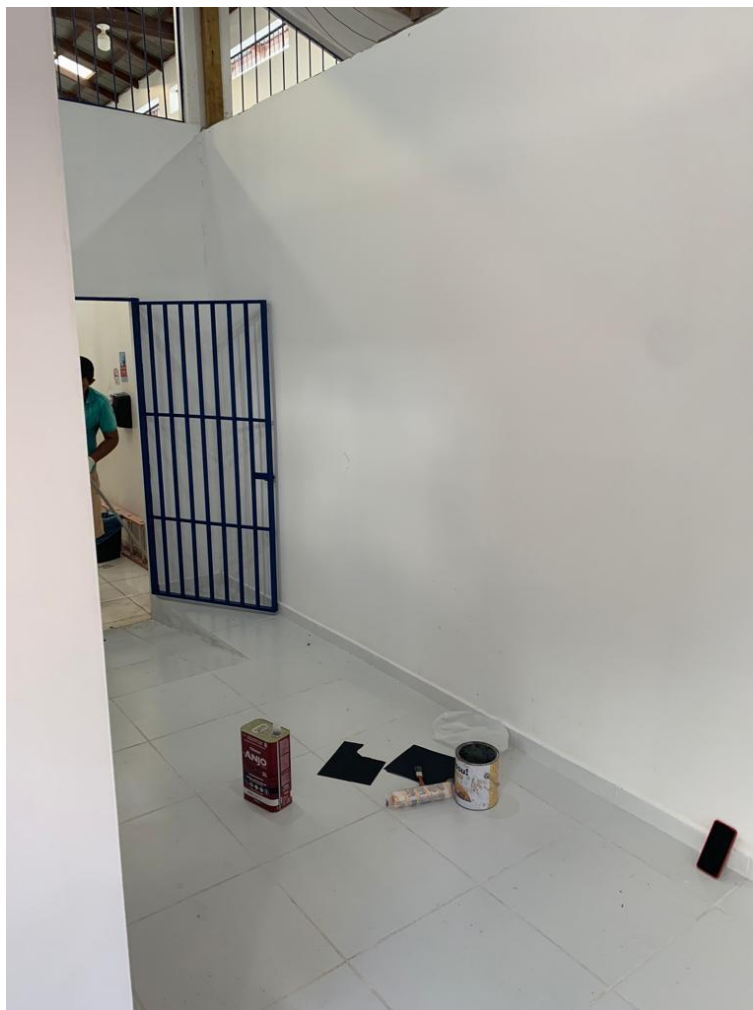
Figura 73 - Emassamento das paredes internas.
