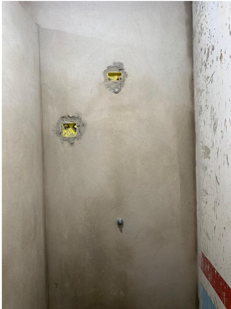
Figura 51 - Execução das aberturas para ventilação.
