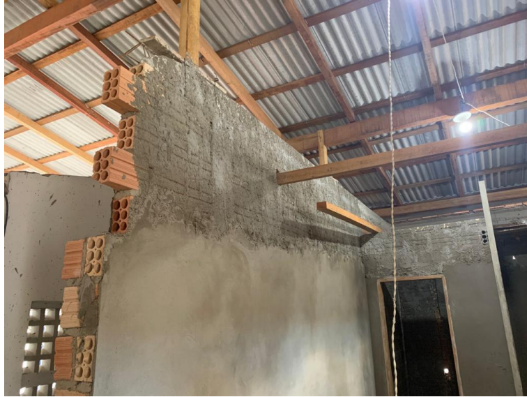
Figura 40 - Reboco parede interna central.
