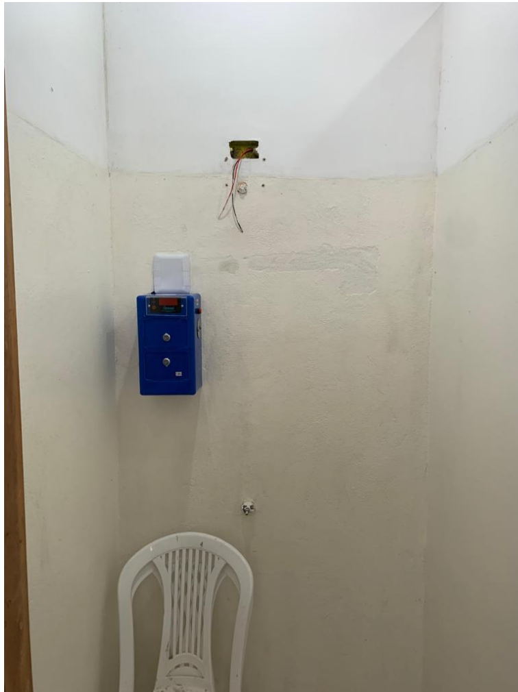
Figura 72 - Instala o dos chuveiros eletr nicos.
