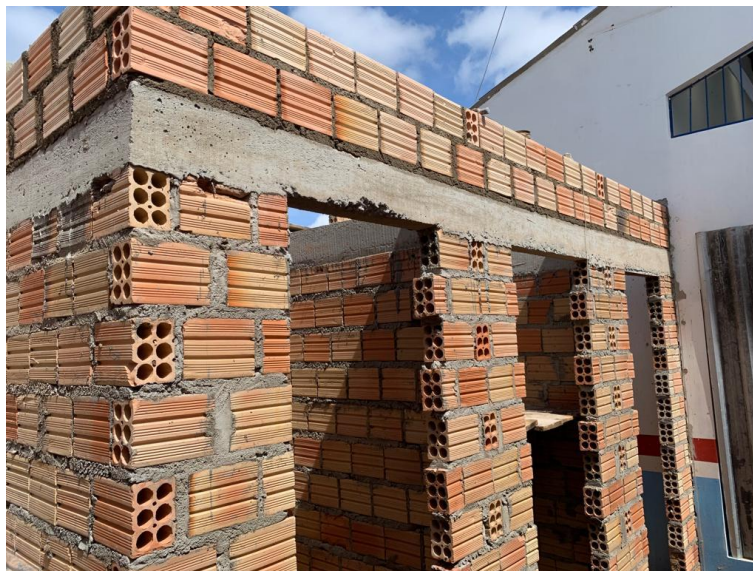
Figura 18 - Viga de sustentação e paredes.
