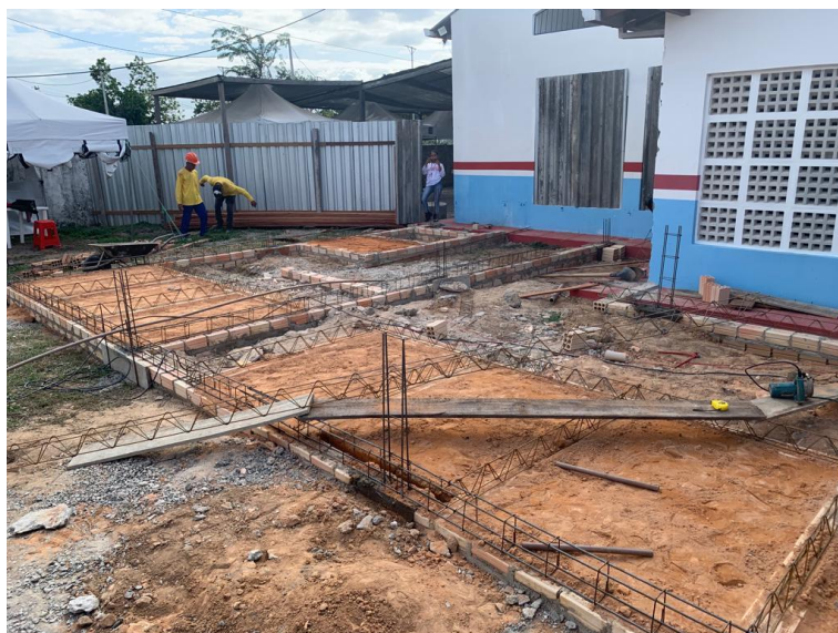
Figura 8 - Continuação do aterramento.
