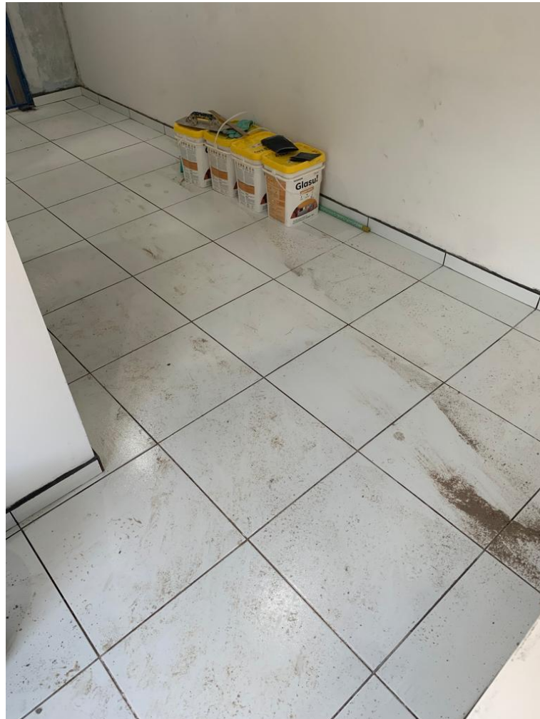
Figura 65 - Finalização do piso com aplicação de rejunte.
