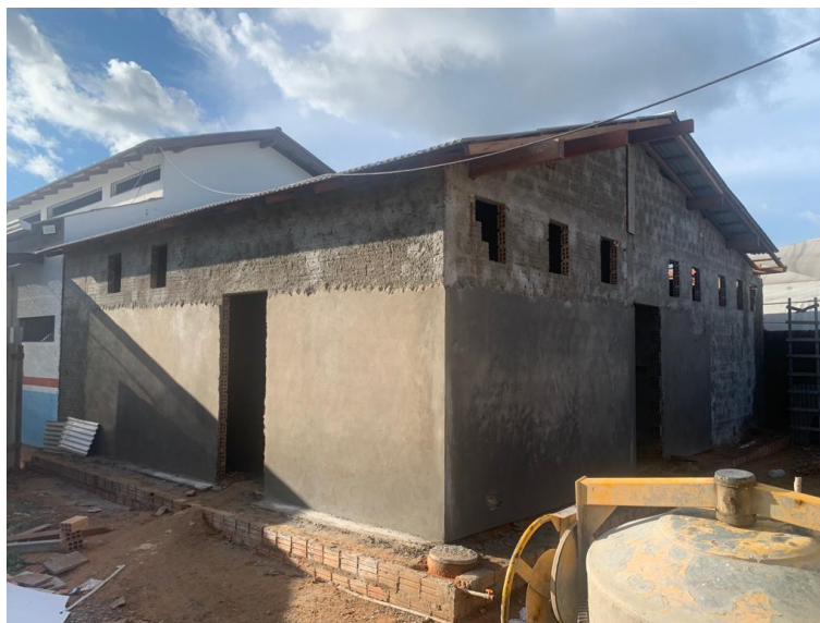
Figura 32 - Continuação do reboco das paredes externas.
