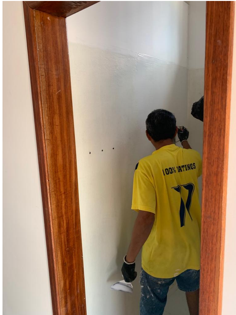
Figura 79 - Emassamento da área dos chuveiros.
