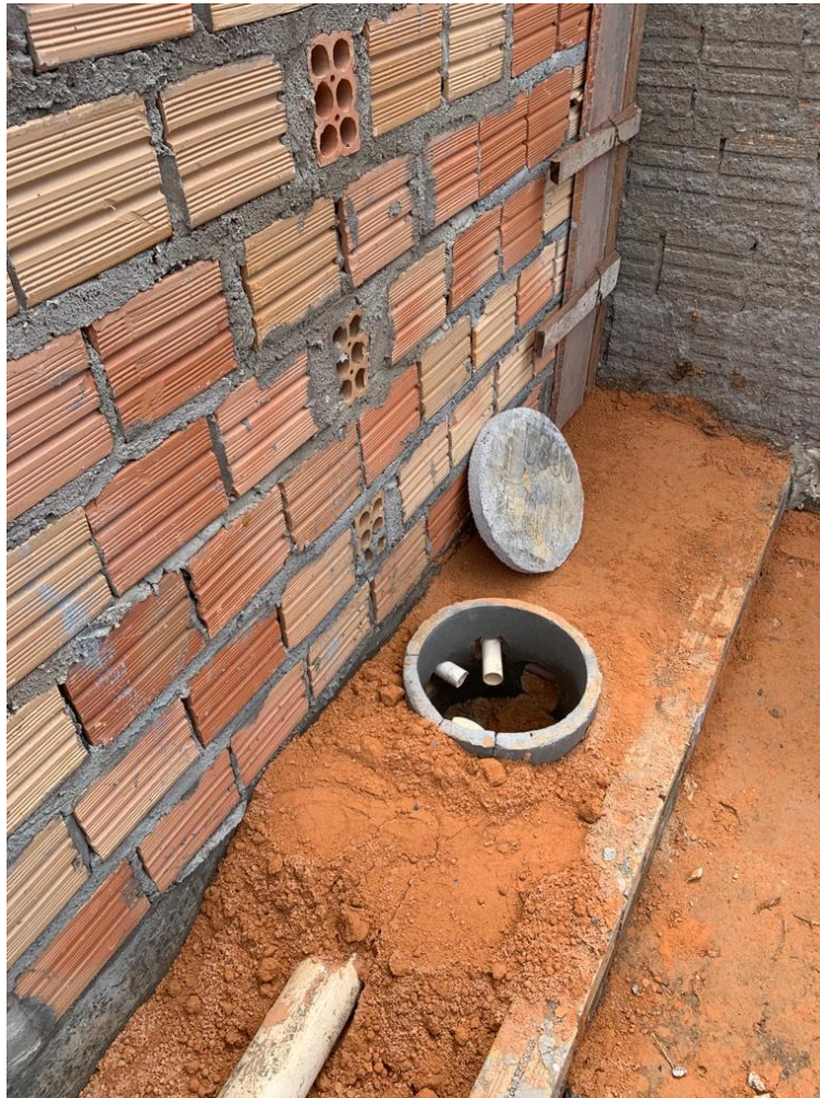
Figura 13 - Aterramento da calçada e caixa de passagem.
